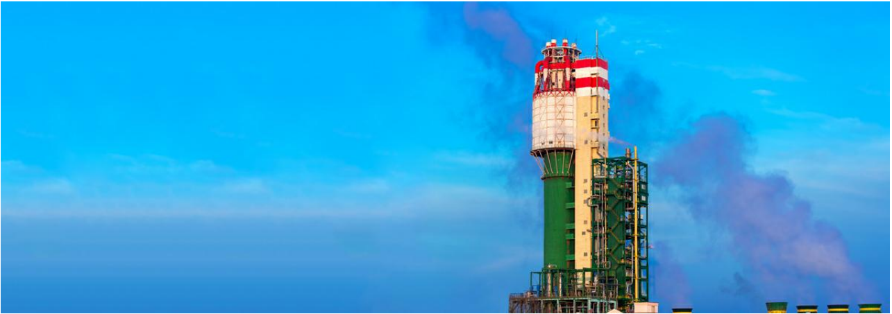
Figura 1. Torre de corriente de salida de una planta de tratamiento químico que produce abono/fertilizante de amoniaco
