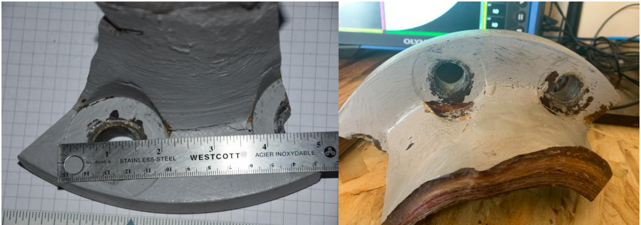
Figura 2. Grieta entre las perforaciones de remaches a partir de un corte de muestra de brida de plástico reforzado con fibra de vidrio
